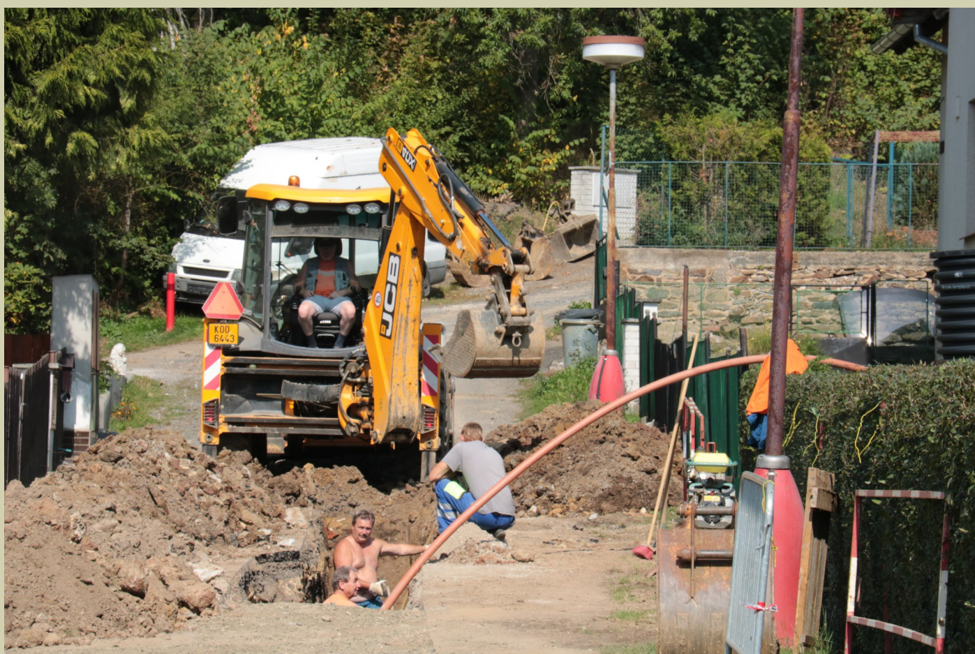
Stavba tlakové kanalizace v ulici V Podzámčích
