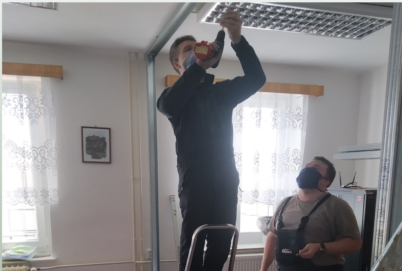
Rekonstrukce kanceláře a kuchyňky
